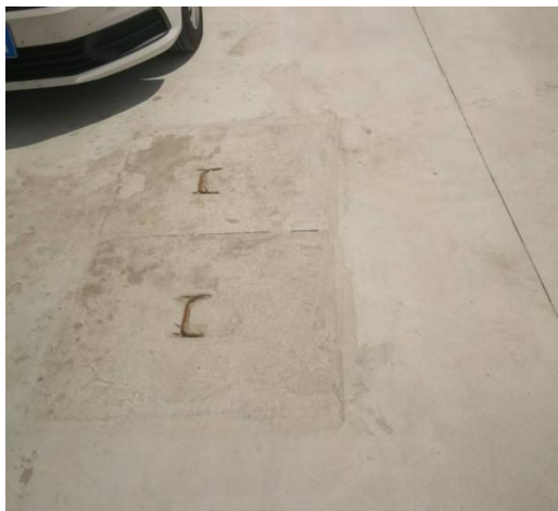
隔油池+化粪池
